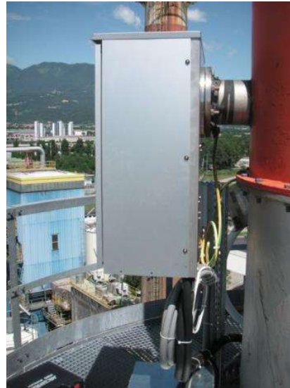
Installation de l'unité de prélèvement
