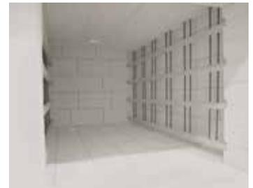
Grille de protection placée devant les éléments chauffants pour prévenir les détériorations mécaniques
