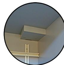
Orifices de ventilation avec thermofusible
